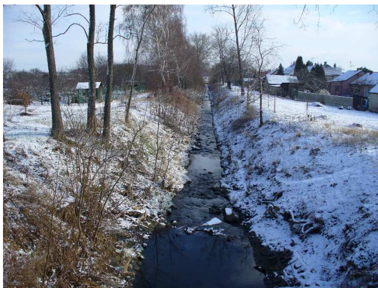
obr. 9 – úsek 04, pohled po proudu z mostu, ulice Bělomlýnská
