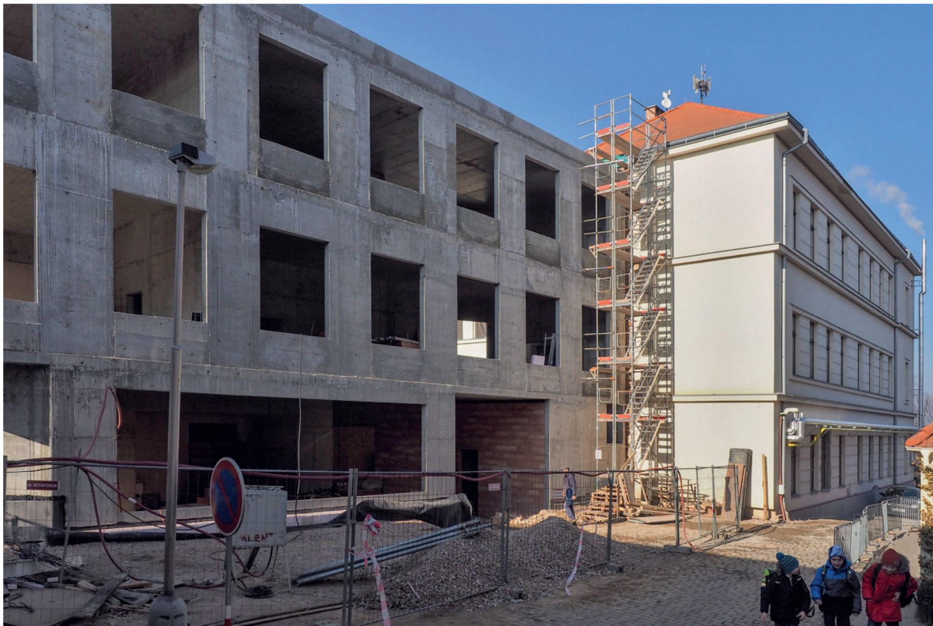
Dokončování železobetonového skeletu přístavby
