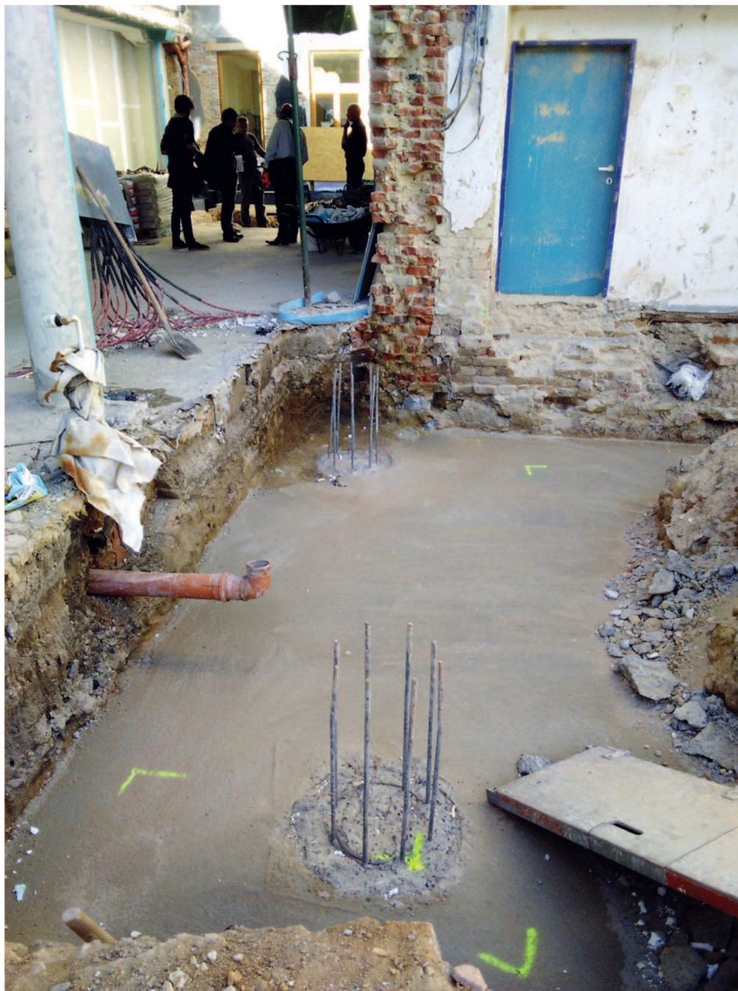
Betonování základů přístavby
