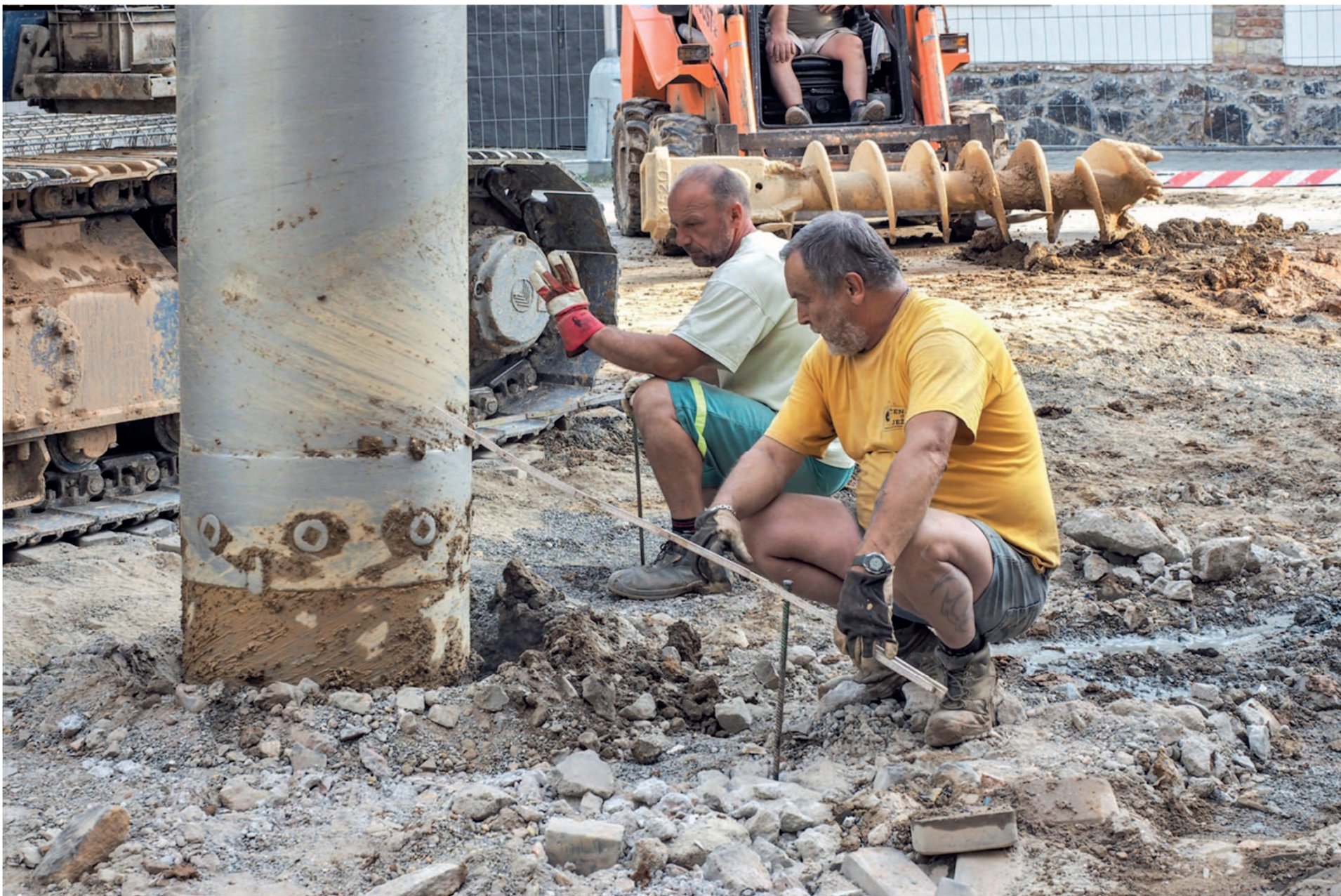
Vrtání základových pilot nového křídla budovy
