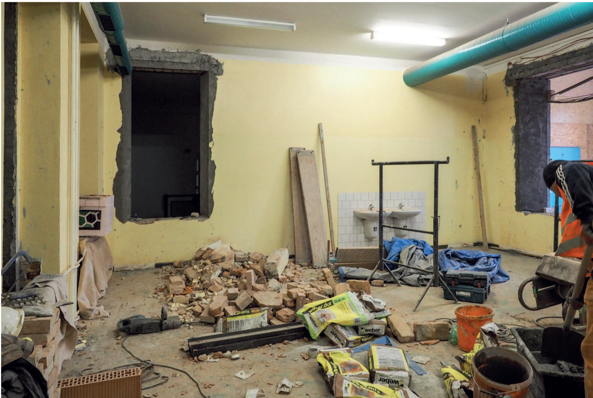
Optimalizace původních vnitřních prostor dle projektu přestavby
