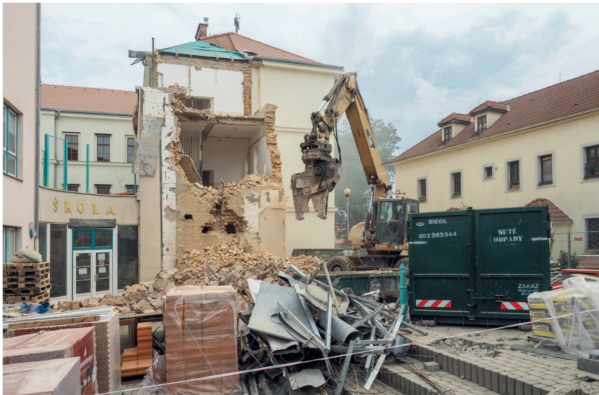
Mechanizovaná demolice původního křídla budovy
