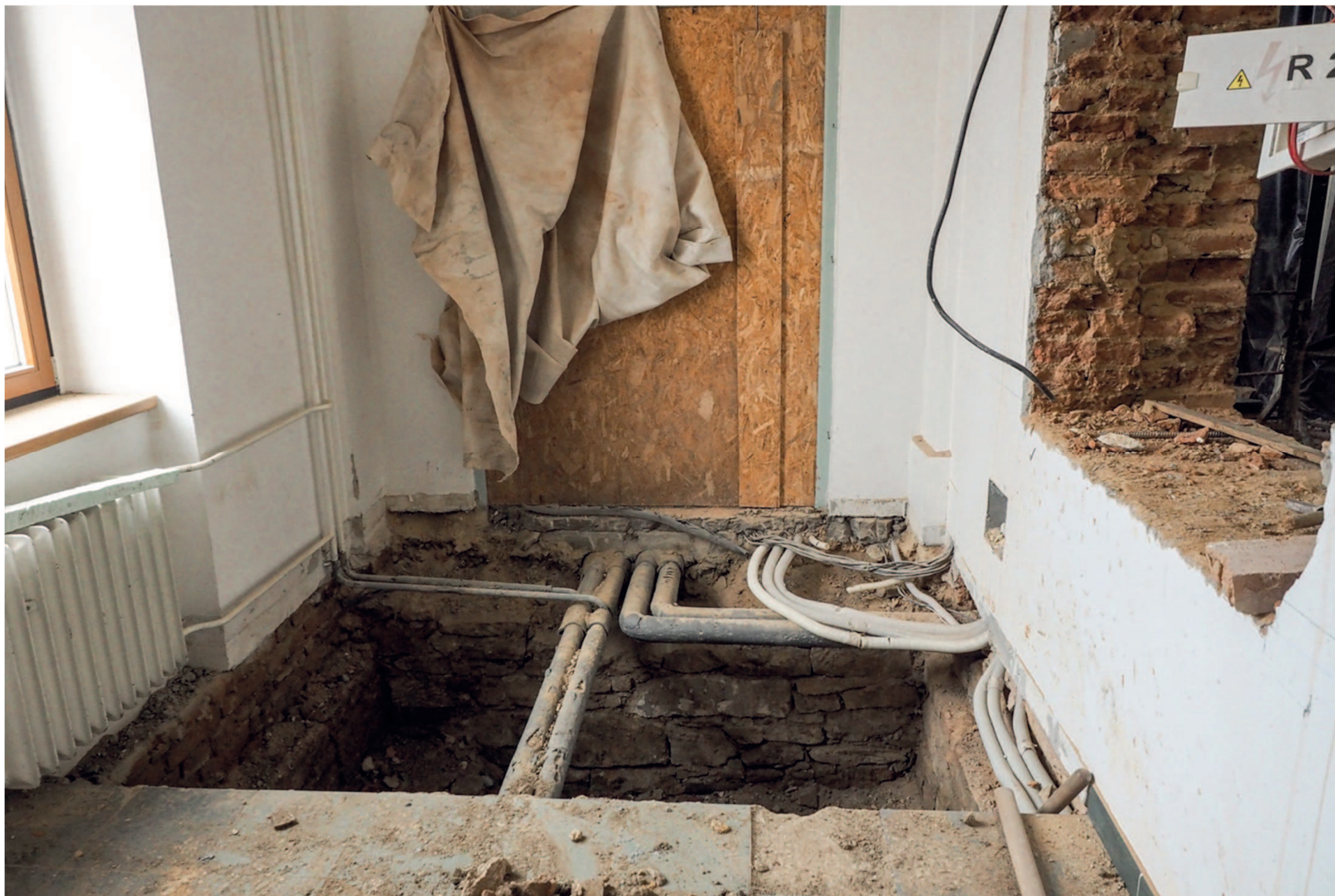
Rekonstrukce původních technických rozvodů
