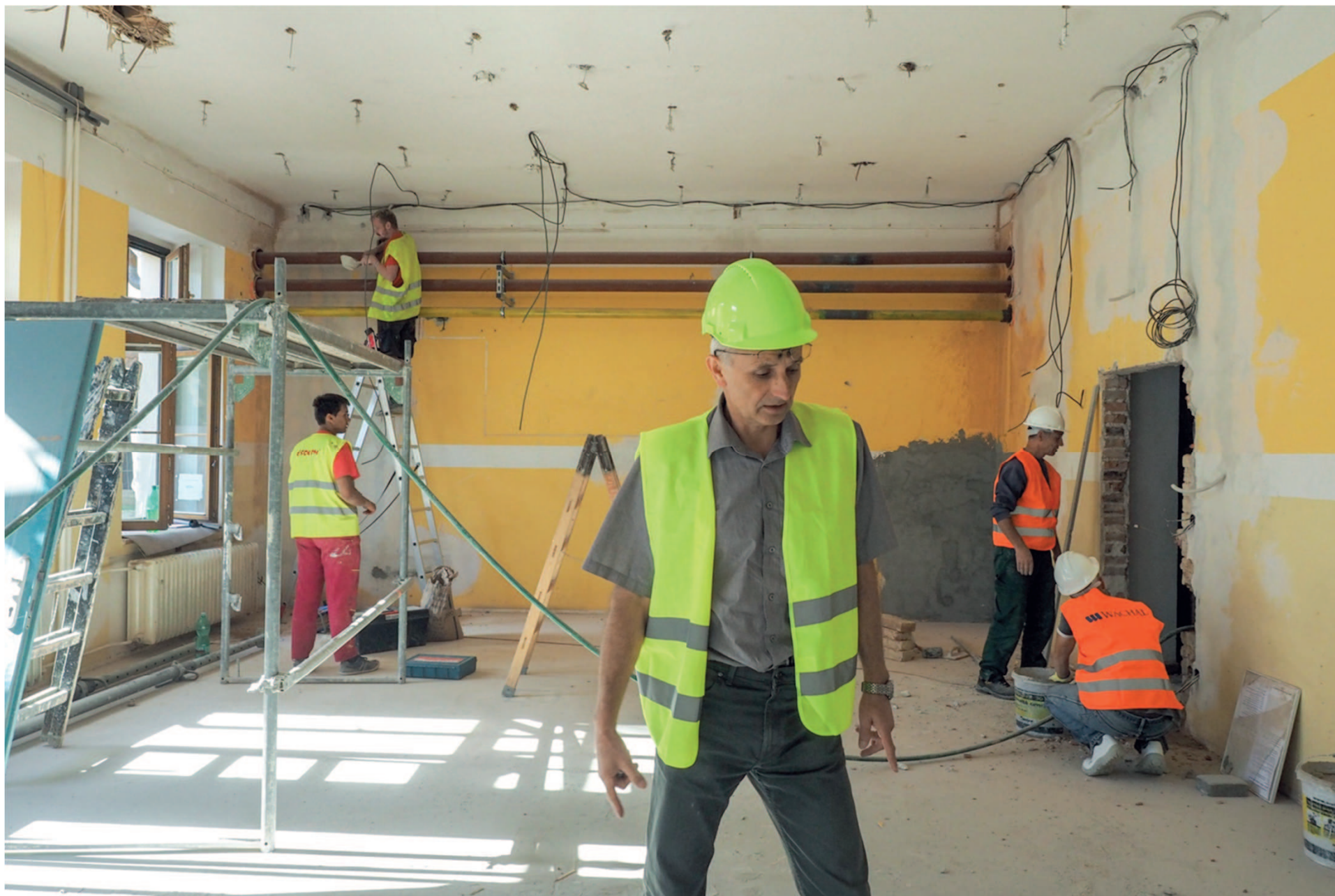
Rekonstrukce stávajících učeben, instalace akustických podhledů a elektrických rozvodů
