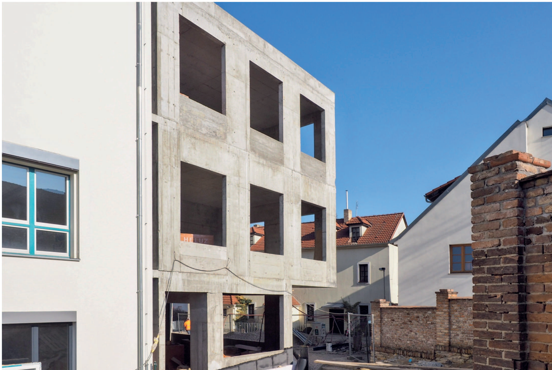
Dokončování železobetonového skeletu přístavby
