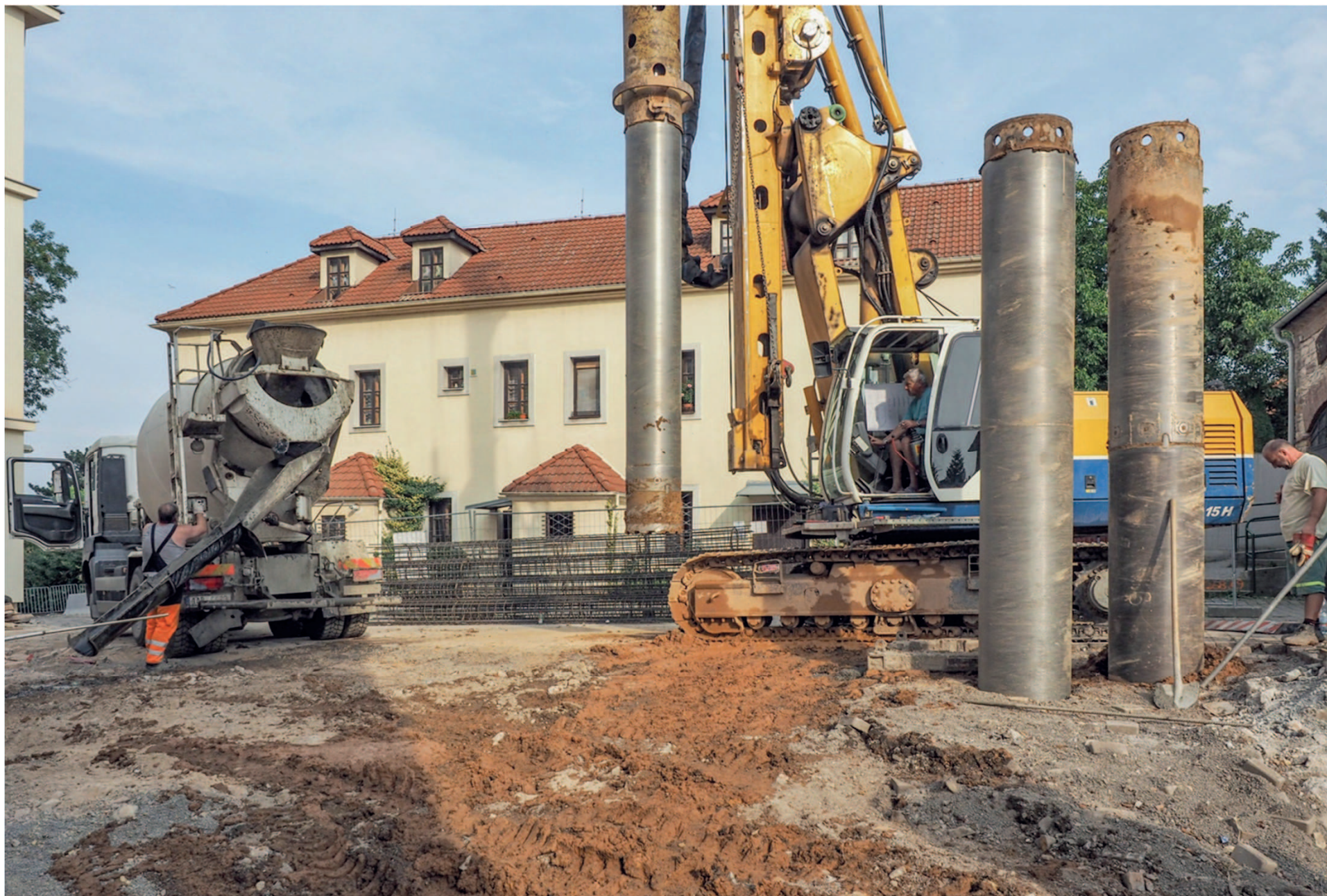
Vrtání základových pilot přístavby
