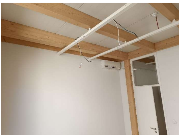
Zhodnocení – klimatizace instalovaná dodatečně
