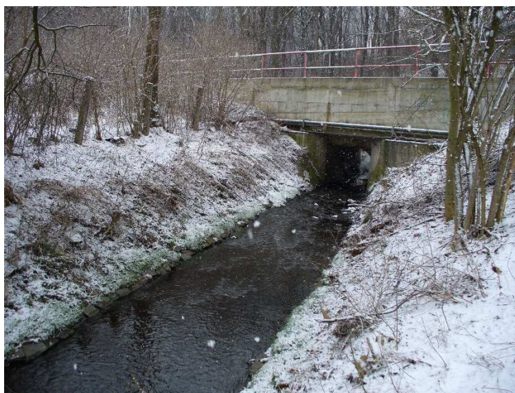
obr. 4 – úsek 02, pohled po proudu na objekt č. 1, navržený k rekonstrukci
