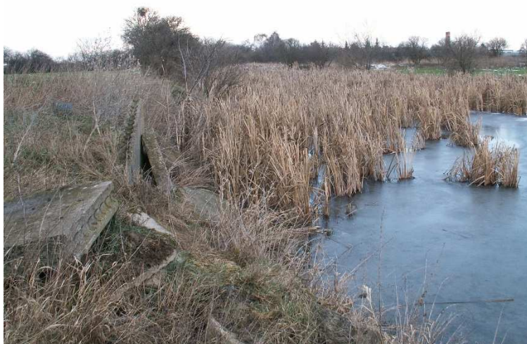
obr. 42 – úsek 17, prameniště, betonové panely na březích
