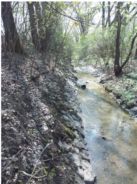
Obr. 9.19 Koryto Mratínského potoka přibližně v ř. km 10,92-11,0
