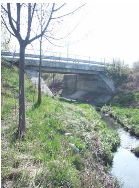
Obr. 9.11 Silniční most u Červeného Mlýna v ř. km. 13,735
