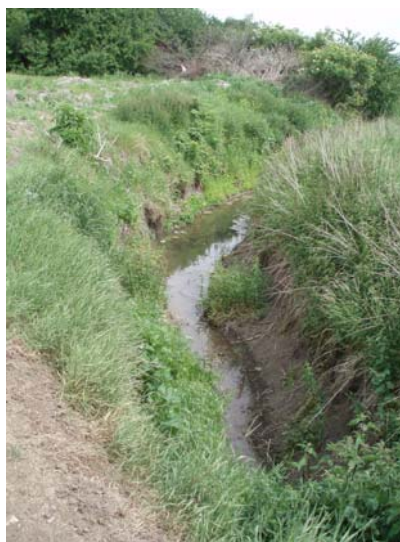
Obr. 9.6 Nezpevněné koryto Mratínského potoka pod Ďáblickým rybníkem
