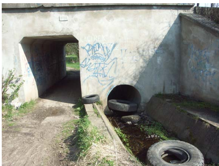
Obr. 9.25 Vtok do propustku pod železniční tratí ř. km 2,776
