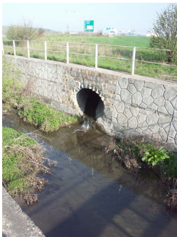
Obr. 9.7 Výúst' V20_MIS dešť'ové kanalizace – odvodnění dálnice
