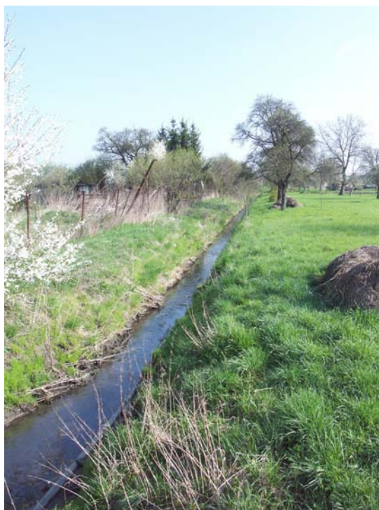
Obr. 9.44 Část úseku s nízkou kapacitou po soutoku Mratíského potoka s bezejmennou vodotečí (ř. km cca 14,20-14,285)
