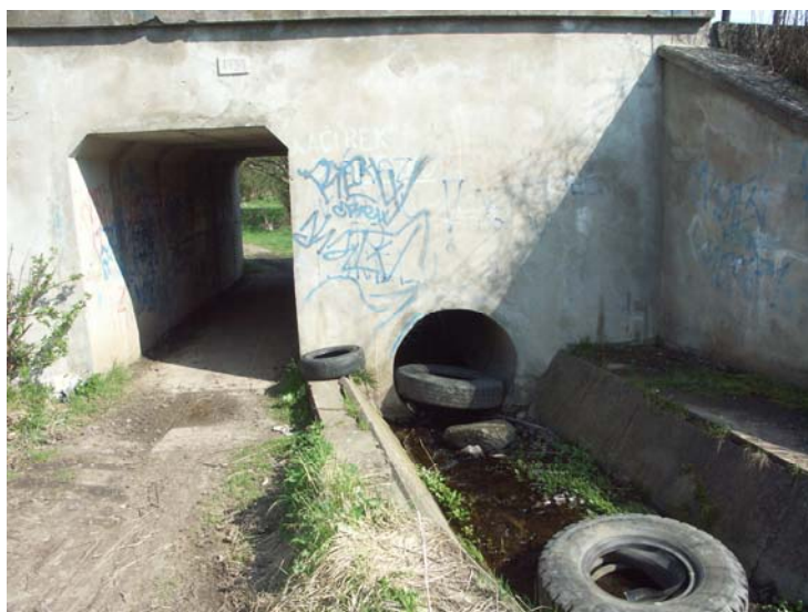
Obr. 9.46 Vtok do propustku pod železniční tratí ř. km 2,776
