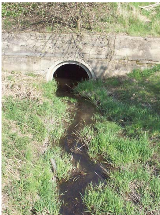
Obr. 9.45 Vtok do propustku pod silnicí k teplárně Třeboradice v ř. km 2,845
