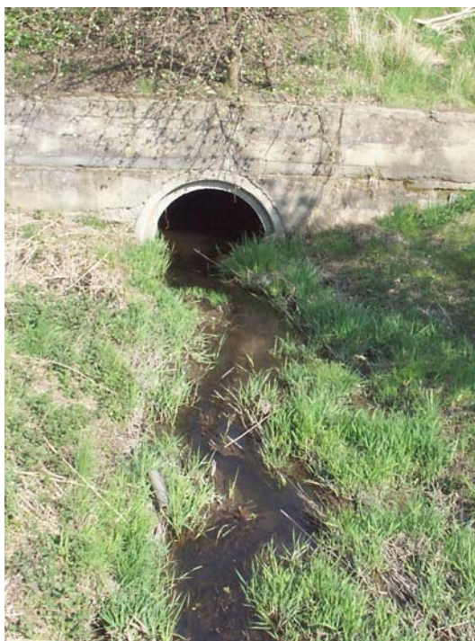
Obr. 9.24 Vtok do propustku pod silnicí k teplárně Třeboradice v ř. km 2,845
