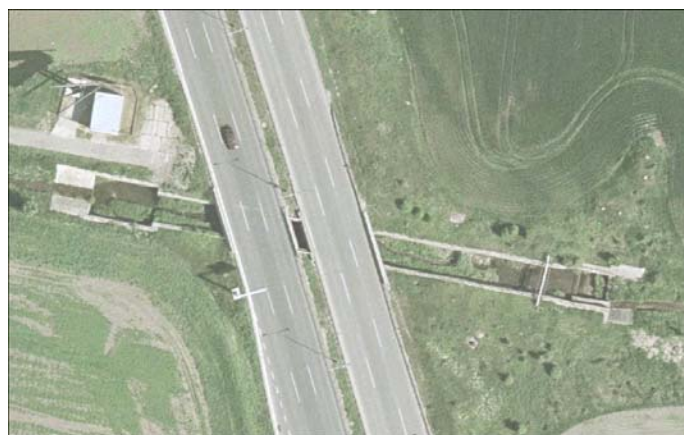
Obr. 9.8 Křižení Mratínského potoka s dálnicí
