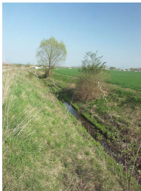
Obr. 9.21 Koryto Třeboradického potoka přibližně v ř. km 5,0 -5,2 (mezi Březiněvsí a PČOV Březiněves)
