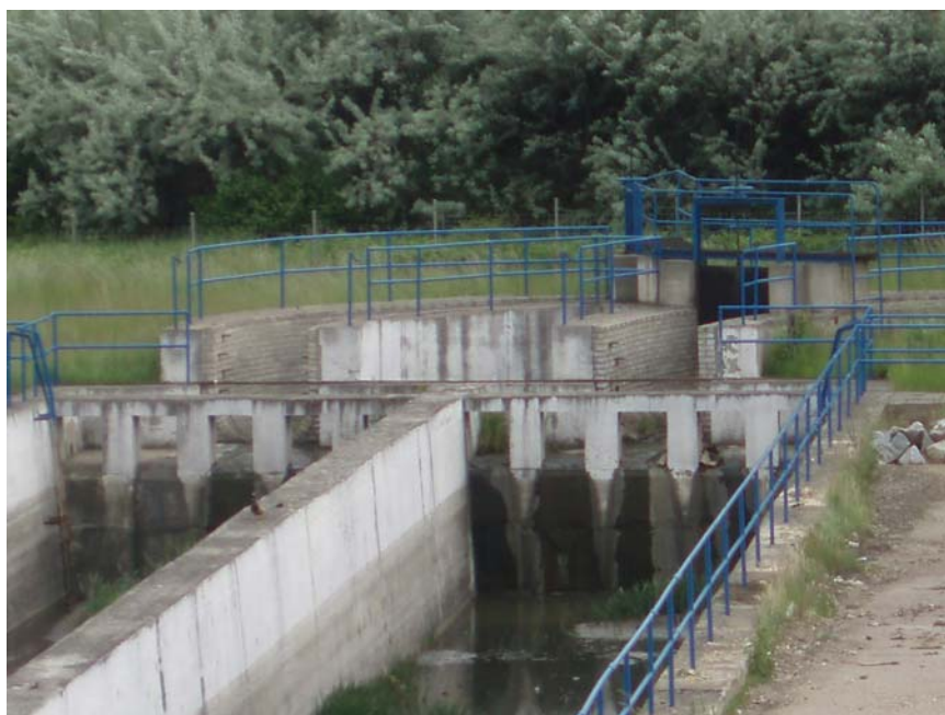
Obr. 8.5 DUN Prosek I u dálnice (směr Teplice) po pravé straně – rozdělovací objekt
