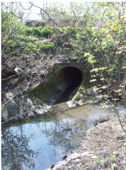
Obr. 9.17 Výúst' z odlehčovací komory OK4_8 Schoellerova
