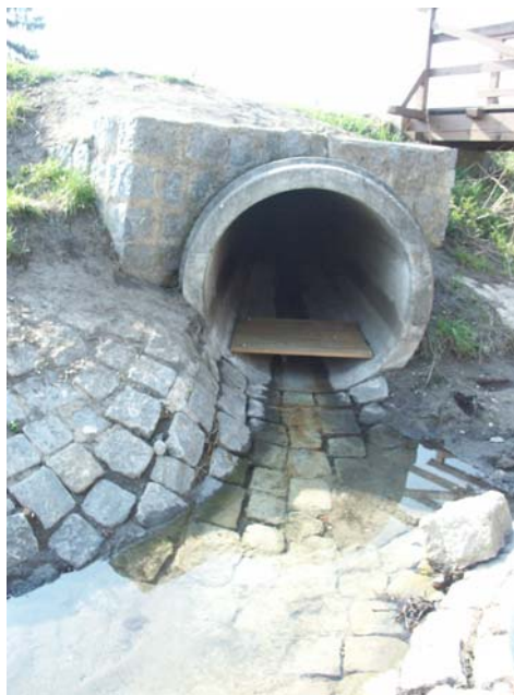
Obr. 9.20 Výúst' dešťové kanalizace v Březiněvsi v ř. km 5,26
