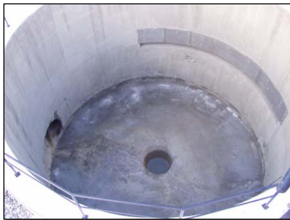
Obr. 6.2 Rozbočná komora nad vírovým separátorem. Pravá větev DN 800 je vedena na PČOV Miškovice, levá větev DN 1400 na separátor (foto PVK, a.s).
