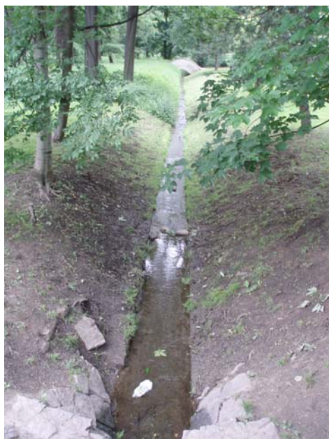
Obr. 9.16 Letňanský potok v bývalé zámecké zahradě v Čakovicích
