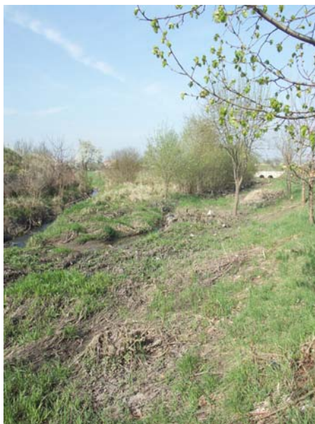
Obr. 9.10 Soutok obou větví Mratínského potoka v ř. km 13,87 (vpravo je patrný výustní objekt zaklenuté trati (2x DN 1400))
