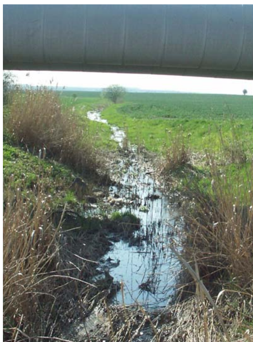
Obr. 9.23 Koryto Třeboradického potoka v místě křížení s teplovodem v ř. km 2,915
