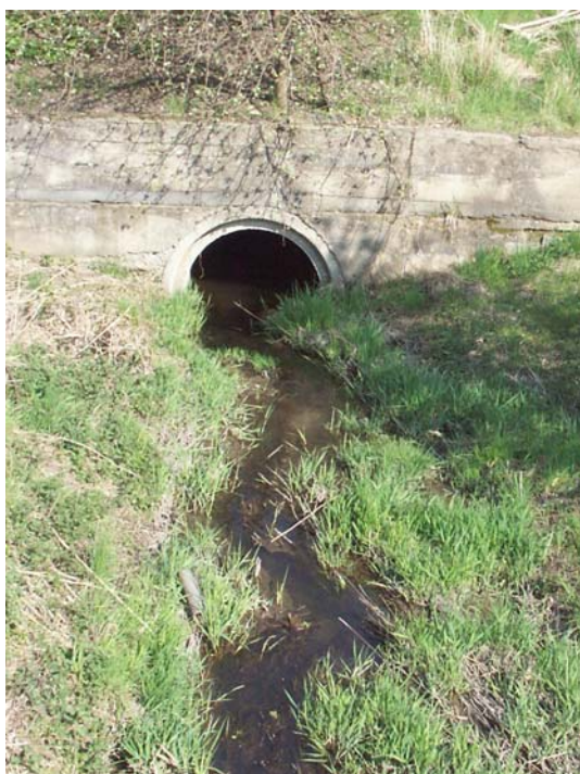
Obr. 6.8 Vtok do propustku pod silnicí k teplárně Třeboradice v ř. km 2,845
