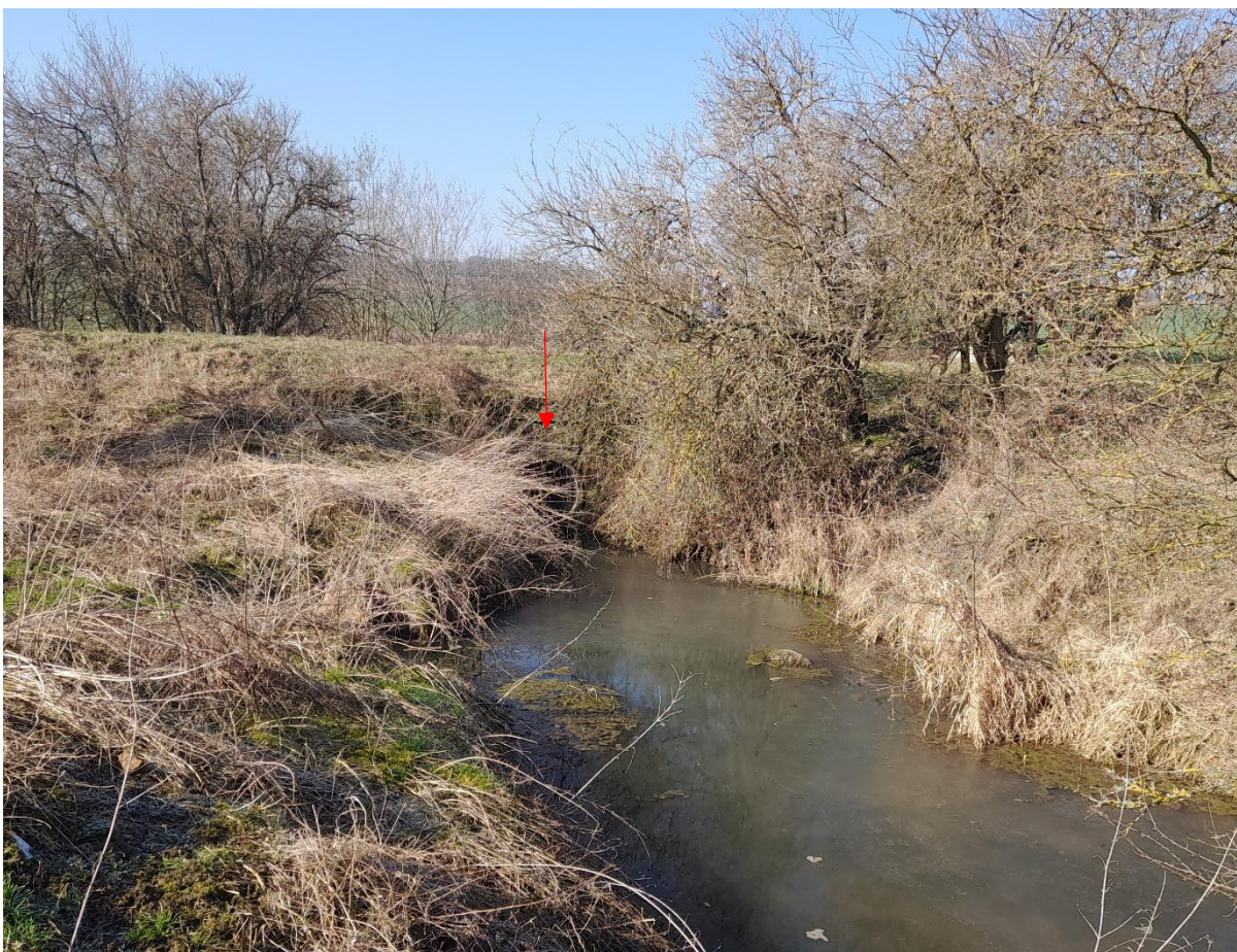
Obr.č. 12 foto – Mratínský potok – výtok z propustku DN 1000 pod polní cestou p.č. 1592
