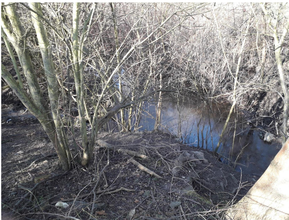
Obr.č. 16 foto –Mratínský potok – koryto před vtokem do propustku DN 1700 pod Ďáblickou ulicí
