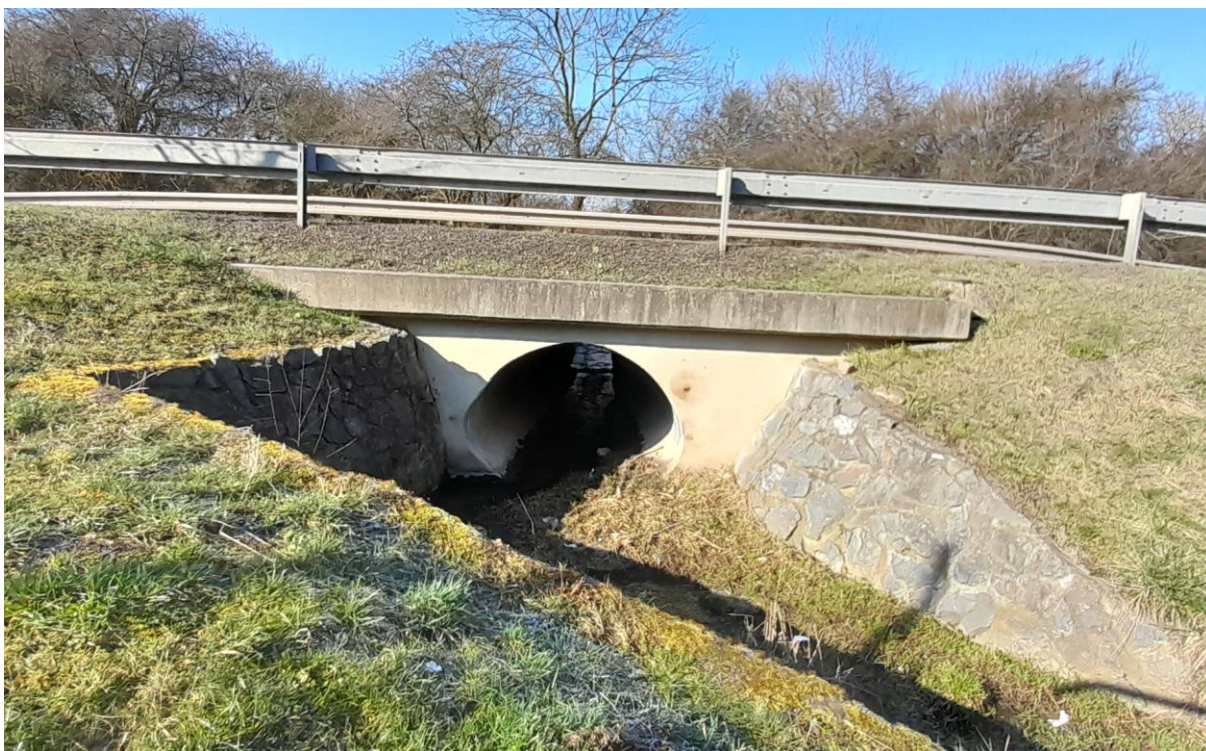
Obr.č. 18 foto –Mratínský potok – výtok z propustku DN 1700 pod Ďáblickou ulicí
