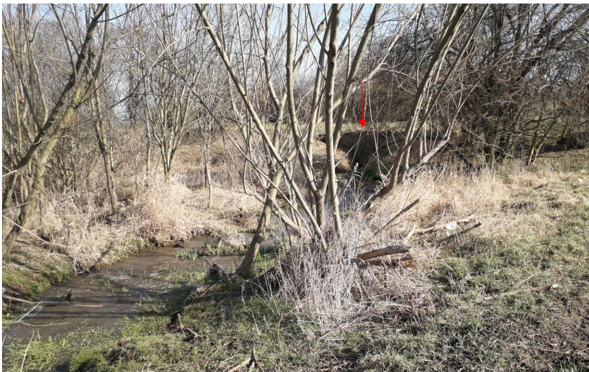
Obr.č. 11 foto – Mratínský potok - charakter toku pod VN Ohrada a vtok do propustku DN 1000 pod polní cestou p.č. 1592
