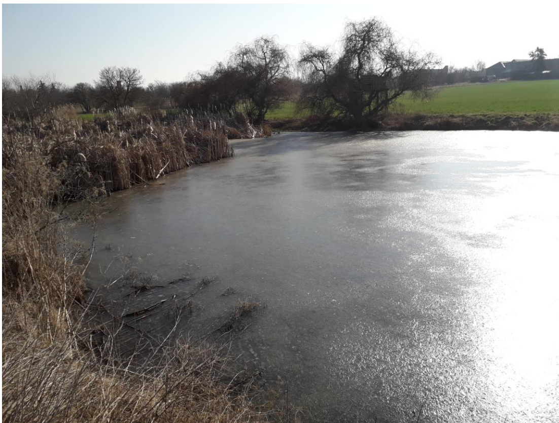
Obr.č. 8 foto – VN Ohrada - odtok z horní nádrže - pohled ze severu
