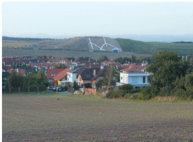
Bílé pruhy – tzv. koberce, jsou určeny k odvodnění jednotlivých vrstev zeminy a jsou součástí procesu rekultivace skládky, která potrvá cca tři měsíce
