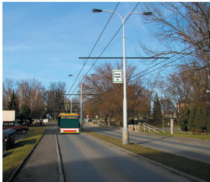
Trolejbus linky 81 jedoucí od Palmovky směřuje ulicemi Ke Stadionu na druhý konec Čakovic. V pozadí za trolejbusem areál čakovického zámku
