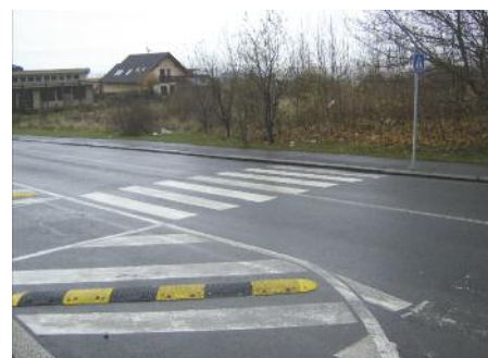
Nový přechod na Ďáblické pod Akcízem
