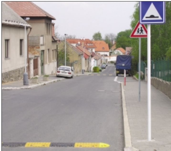
Dva zpomalovací kovové příčné pásy na vozovce v ulici Kvěťmová před Mateřskou školou.
