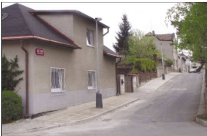
Nově vybudovaný chodník v ulici Ke Kinu (od křižovatky s Ďáblickou).
