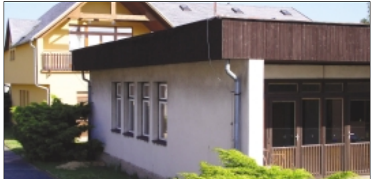
Pavilon MŠ pro další rekonstrukci.
