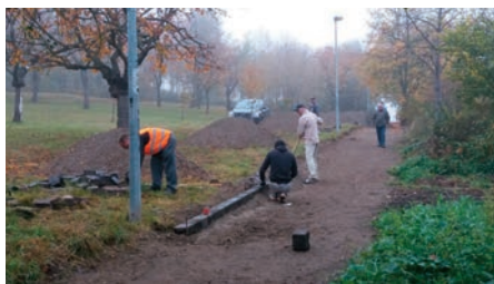
Kladení obrub začíná a využívají se všechny obruby z původního chodníku.
